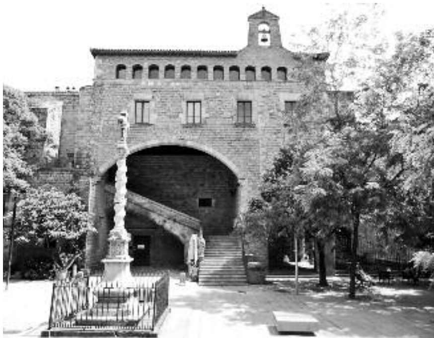
Imatge exterior de l'Hospital de la Santa Creu.
