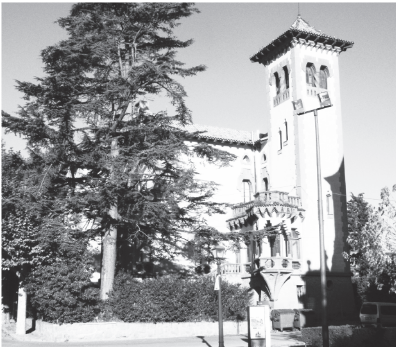
La casa de l'amo de la colònia Viladomiu Vell, al Bages.
