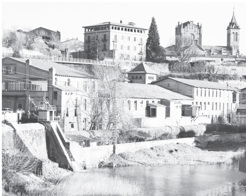
Colònia de Cal Metre, a Gironella, amb la fàbrica i la torre de l'amo en primer pla. Al fons, l'església de Santa Eulàlia.
